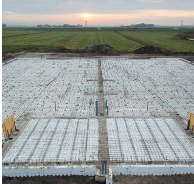
▲ Project Lemmer, Friesland, Niederlande Fußbodenheizung
