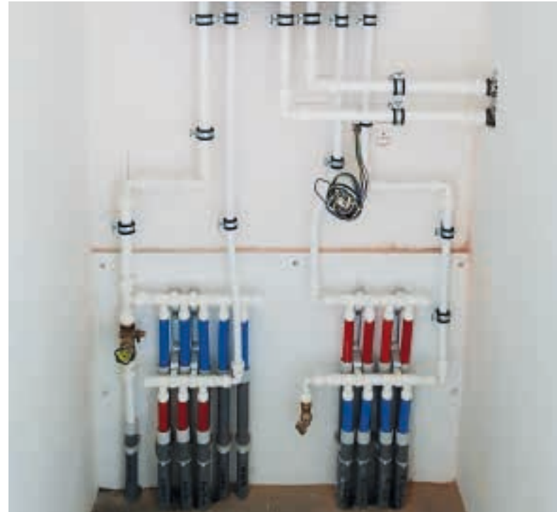
▲ Racores, Belgica Instalación de Henco Vision para fontanería
