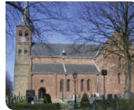
Les Pays-Bas - Chauffage par le sol
