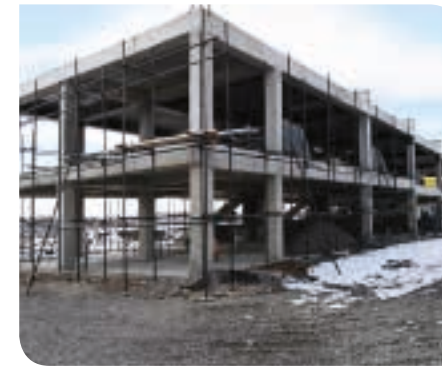
Arménie - Activation du noyau en béton
