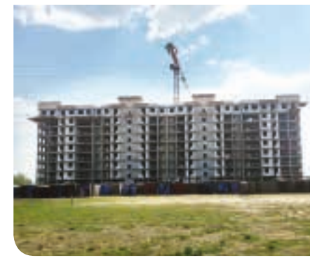
Russie - Chauffage par le sol
