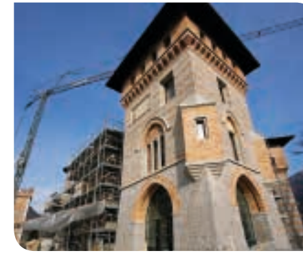
Italie - Chauffage par le sol
