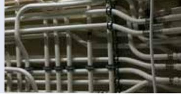
Ist die Steigleitung länger als 10 m, muss ein Fixpunkt angebracht werden. Es ist ratsam diesen Punkt in der Leitungsmitte anzuordnen, da so geringere Ausdehnungskräfte entstehen.
