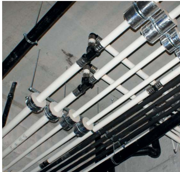
Football stadium, África do Sul ▲ Acessórios de cravar em PVDF para instalações sanitárias
