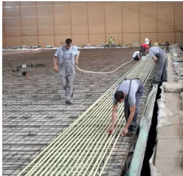
▲ Rink Stadium, Zagreb, Croácia Sistema de arrefecimento para pista interior de patinagem no gelo
