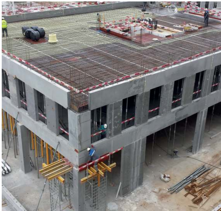
▲ Post X, Antwerp, Bélgica Activação da massa térmica do betão
