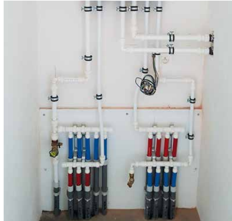
Raccords, Belgique ▲ Installation de Henco Vision pour sanitaire
