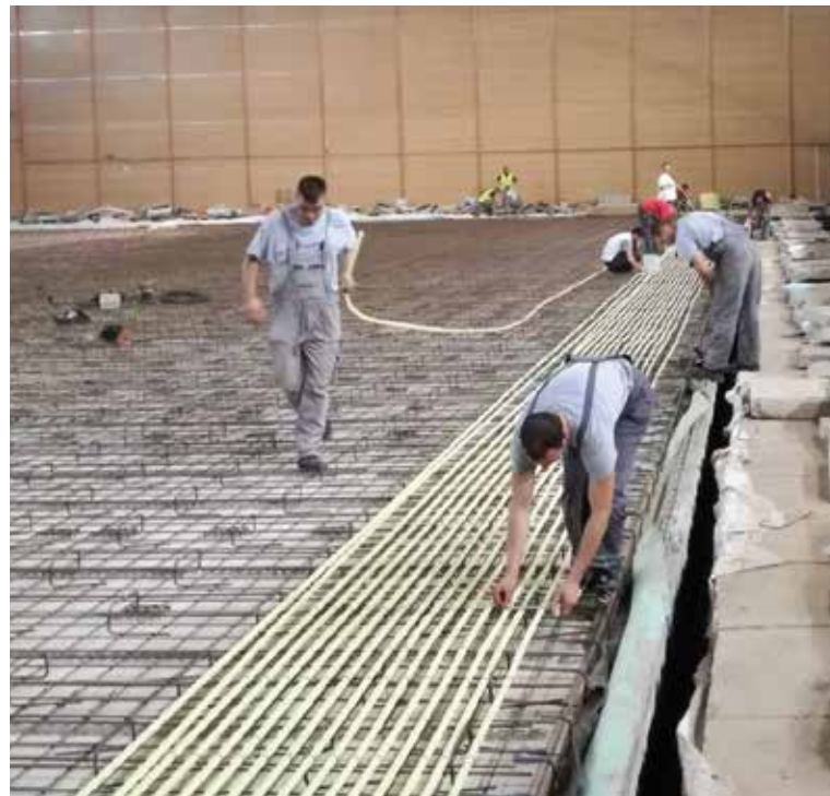
Rink Stadium, Zagreb, Croatie ▲ Système pour refroidissement les pistes de patinage
