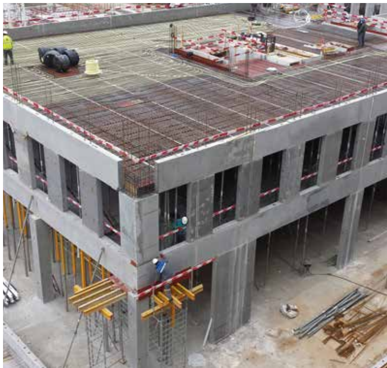
▲ Post X, Anvers, Belgica Activación de la masa termica de hormigon
