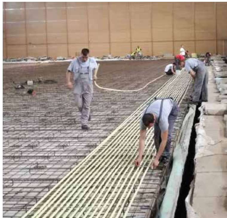
Estado Rink, Zagreb, Croacia ▲ Sistema para refrescamiento de las pistas de patinaje
