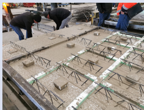
Ingestorte betonelementen. Op de werf worden de rest van het leidingwerk en de sprinklaansluitingen aangesloten.
