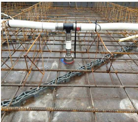
50P sprinklercup gelijmd op metalen bekisting
